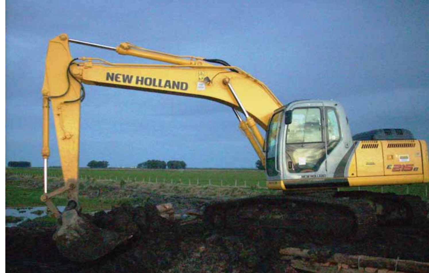
La E215B se utiliza para la limpieza y el acondicionamiento de canales viejos, así como para la construcción de los nuevos.
