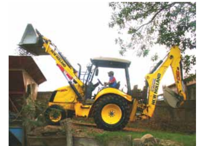
La retroexcavadora New Holland B90B se dedica a la construcción de escuelas, viviendas y caminos.
