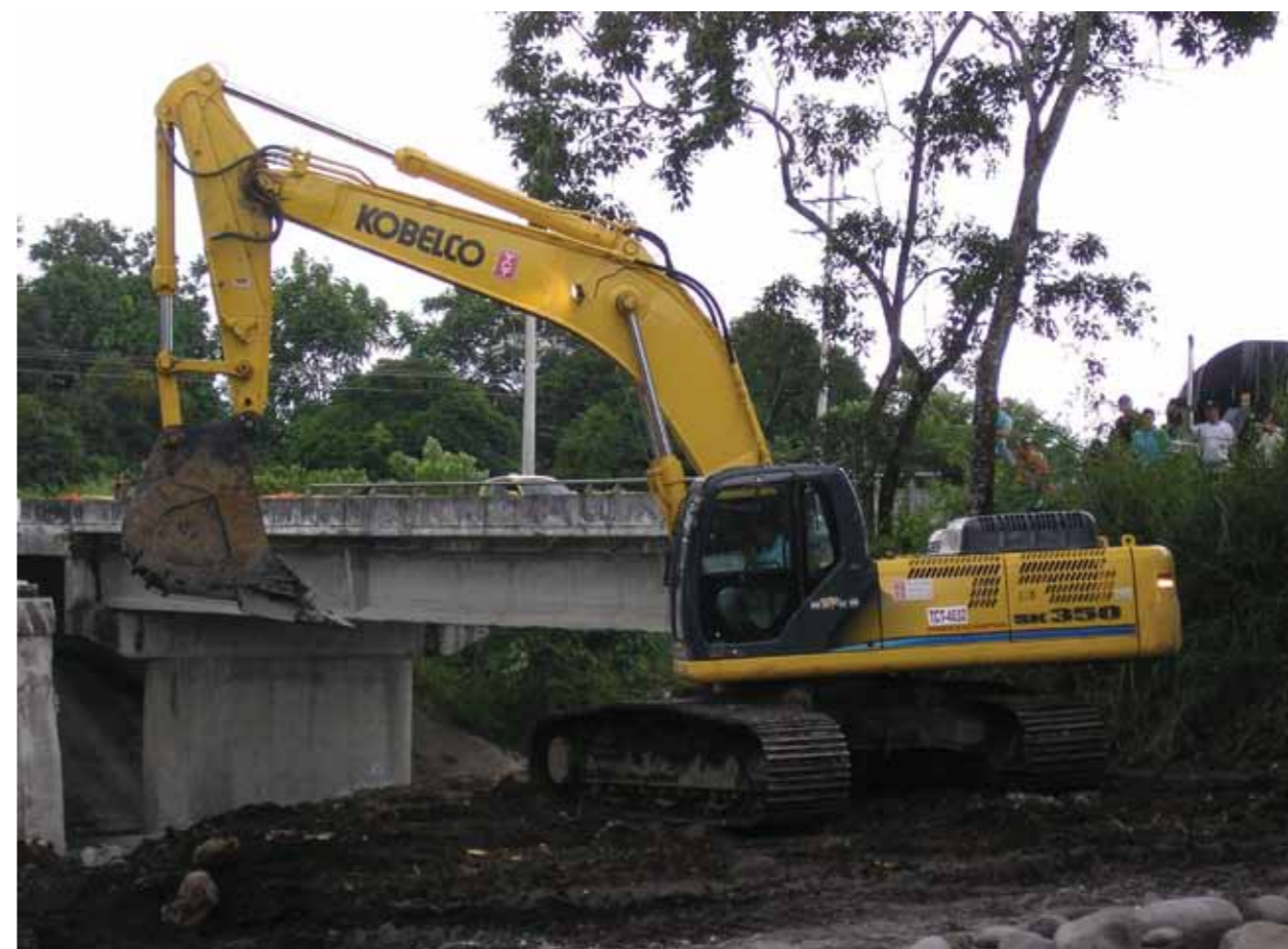
La excavadora ayudará a remover el material del puente que se desplomó debido a las fuertes lluvias que sufrió la provincia de Chiriquí.
