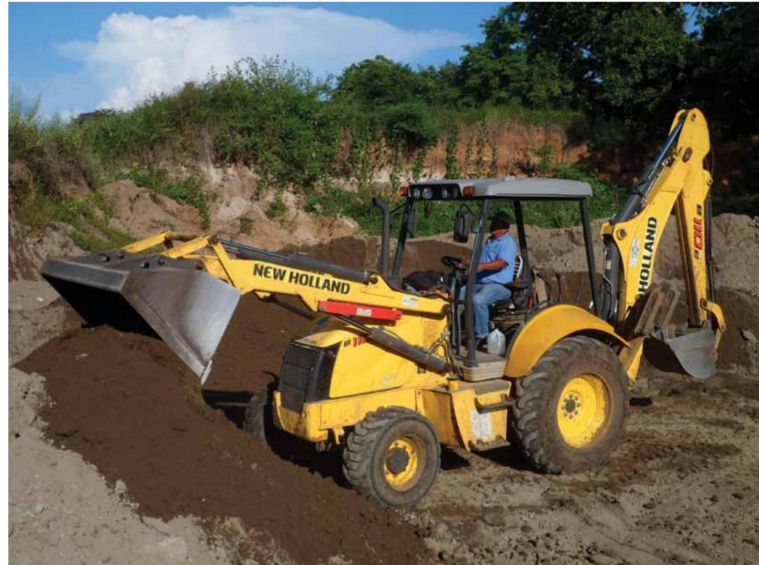
La retroexcavadora B110B trabaja en la explotación del banco de material selecto para proyectos de reparación de caminos y adoquinados.
